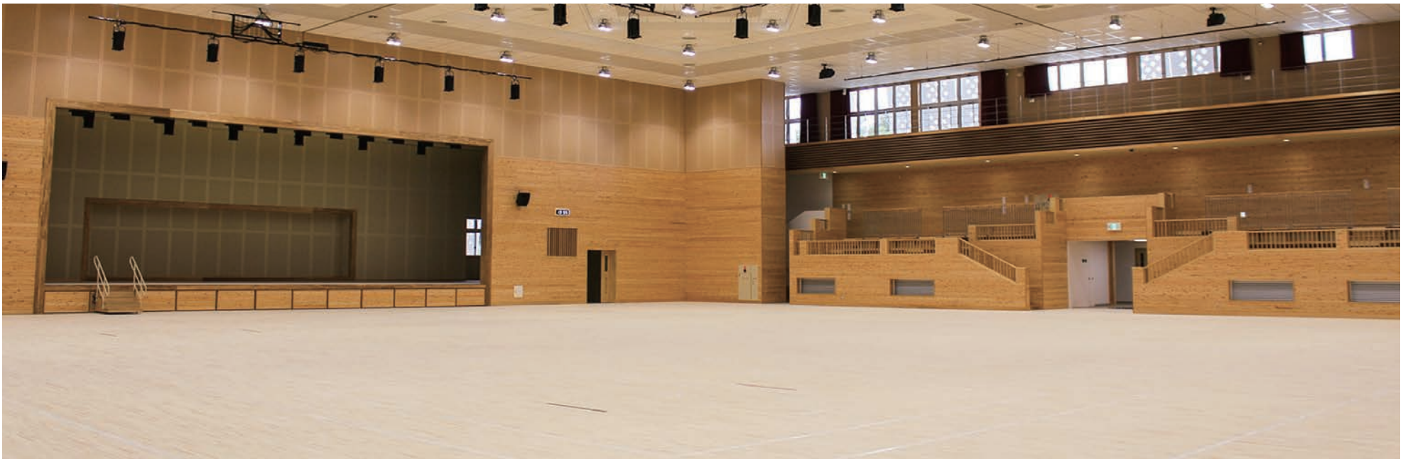
沖縄空手会館 マツ集成フローリング（無節）18mm / 1,820㎡ 防虫防蟻処理
