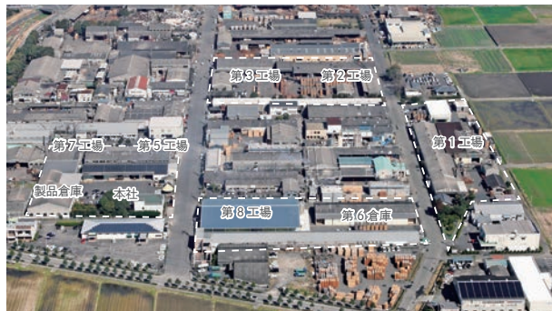
工場全景・敷地面積 11,000 坪
